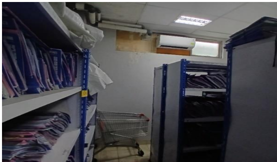
Gambar 2. Posisi Air Conditioner dan Exhaust Fan Pada Ruang Penyimpanan Berkas Rekam Medis
