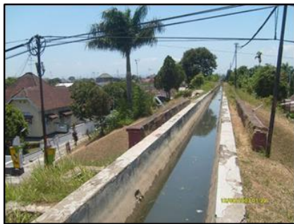
Gambar 3. Saluran air atau sungai
