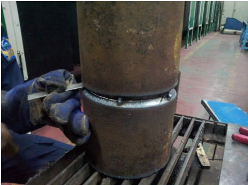
Gambar-5. Persiapan las pipa
