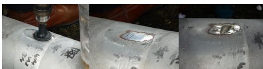
Gambar -3. Proses Pengerindaan dan Pemolesan (Polishing)
