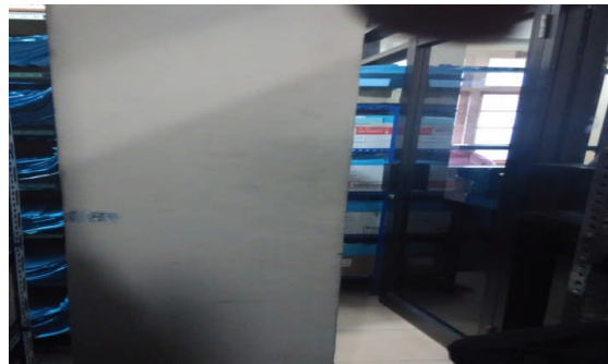
Gambar 16. Pintu lain yang terhubung ke unit lain (Sumber oleh penulis,2015)
